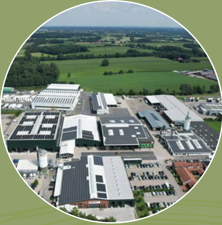
Terhalle Hauptstandort Ahaus-Ottenstein
