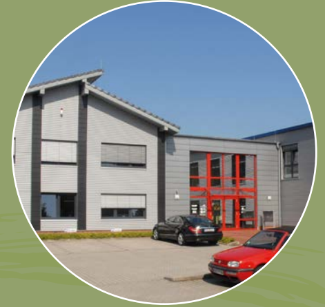
ABV Bedachung und Bautenschutz Aurich
